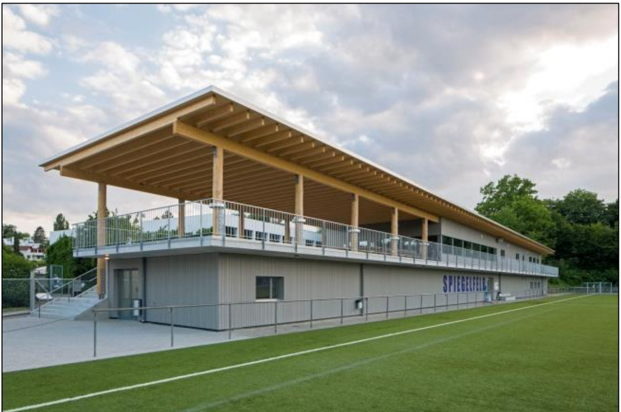
Längsseite (unten Garderoben / oben Clubgebäude mit Terasse)
