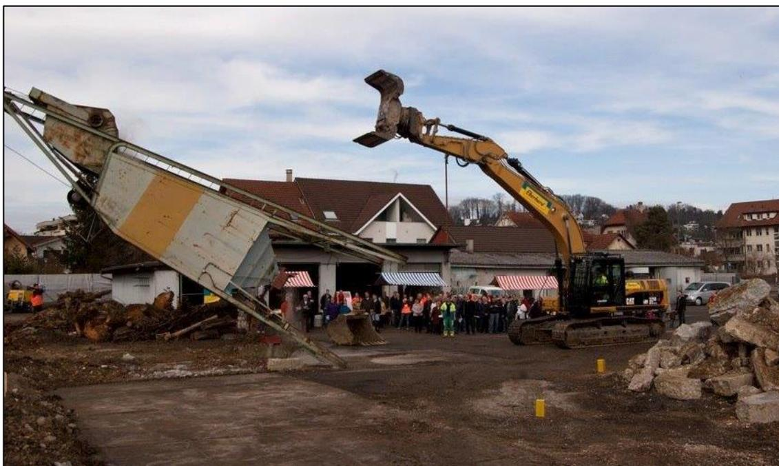
*Foto 1: März 2013, Abbruch des alten Splittsilos als Auftakt zur Deponiesanierung*
