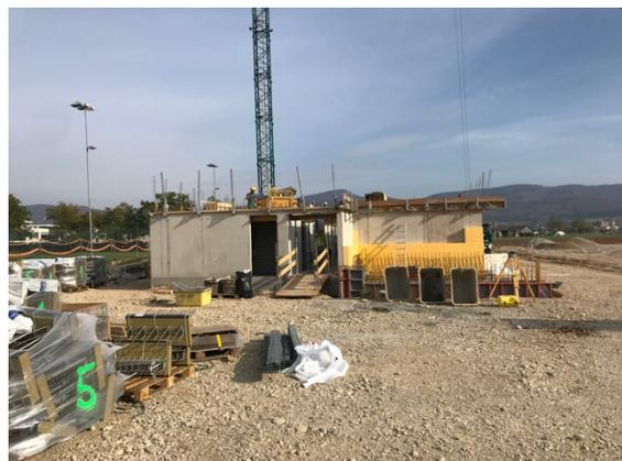
Das Obergeschoss wurde, mit Ausnahme des Liftschachtes als reiner Holzbau realisiert und mit grossen, im Werk vorfabrizierten Elementen aufgebaut. Die Fassade wurde im Erd- wie Obergeschoss einheitlich mit einer vertikalen Holzbeplankung versehen.
